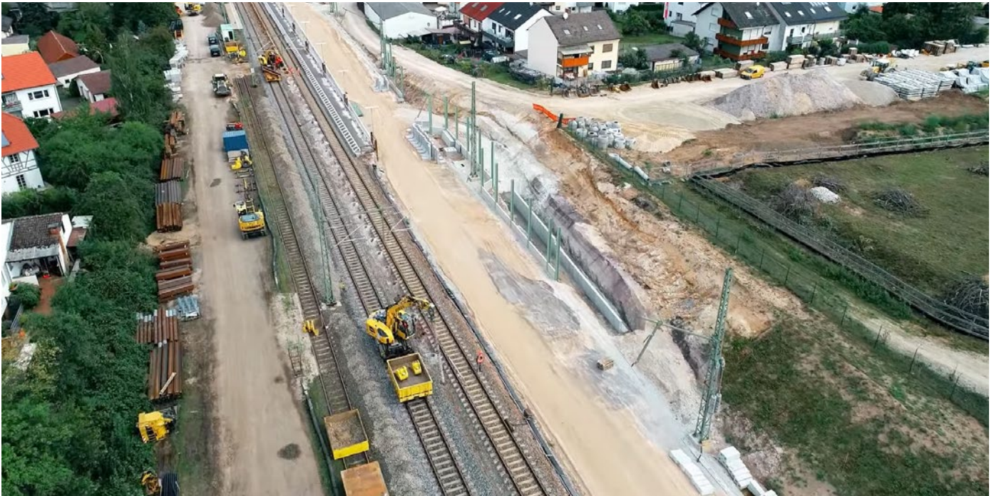
Abb. 1: Baustelle Haltepunkt Hallstadt-Breitengüßsbach
